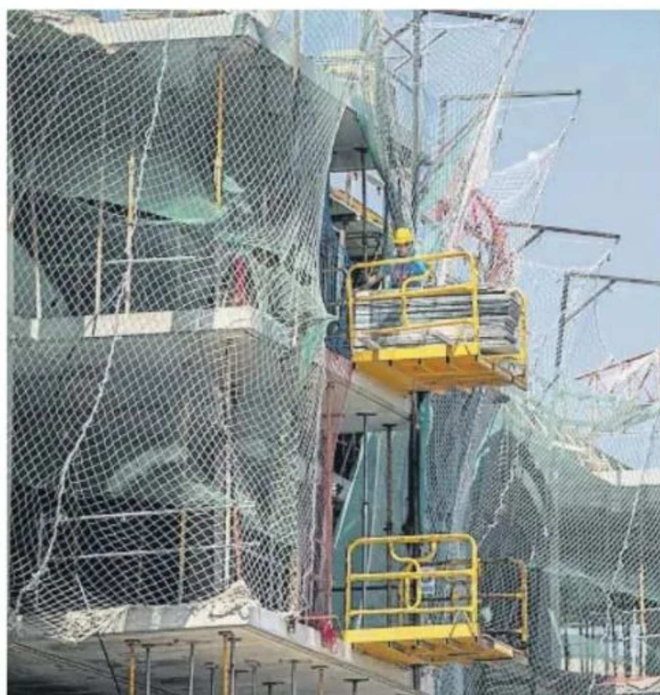
Viviendas en construcción en Sant Cugat del Vallès
